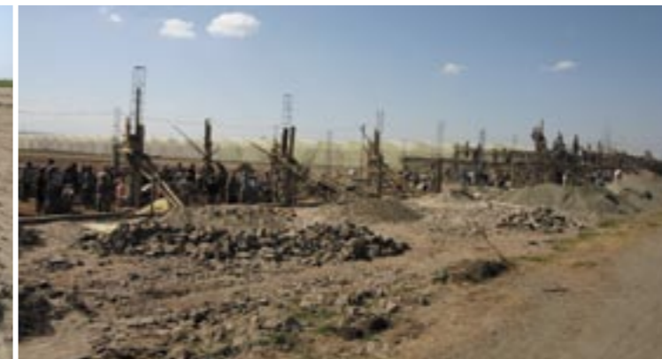
Dagelijks werken zo'n 1.300 mensen in de bouw. Hier worden funderingen gelegd.
